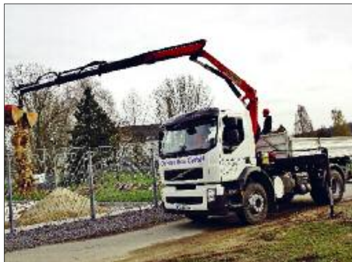
Mitarbeiter Olaf May von der Oehme Bau GmbH Niederwiesa transportiert Sand in den künftigen Spielplatzbereich. Foto: Knut Berger
