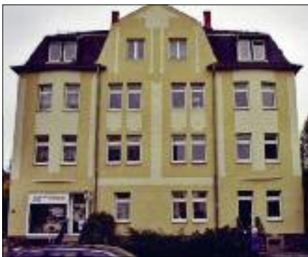
Die renovierte „43“ (Straßenseite)
