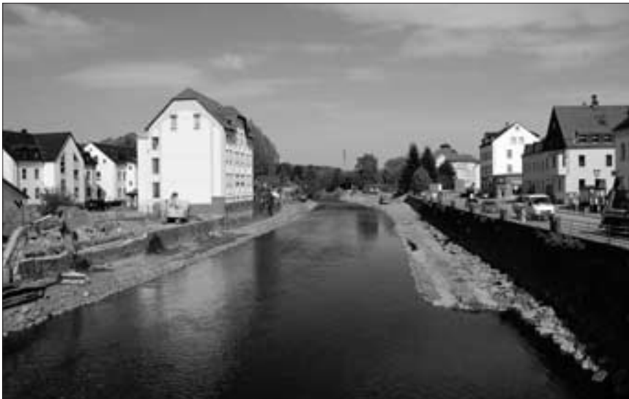
Baumaßnahmen für den Hochwasserschutz am Verlauf der Zschopau.
